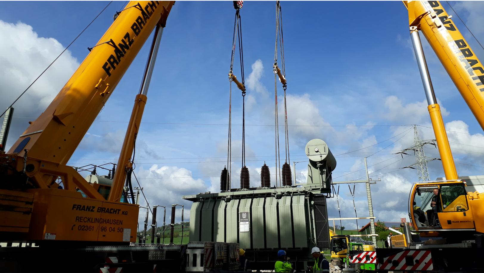
Zwei Kräne heben den Trafo auf dem Gelände des Umspannwerks an einen anderen Standort.
