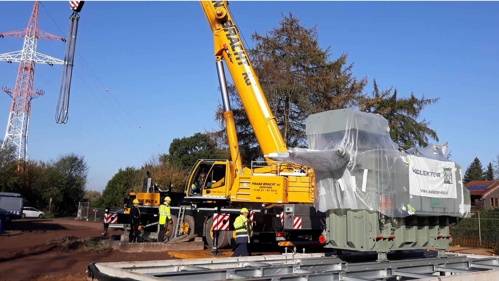
Westfalen Weser Netz modernisiert Umspannwerk Lahde: 50 Tonnen schwerer Trafo wurde jetzt per Schwerlastkran auf sein Fundament gehievt.
