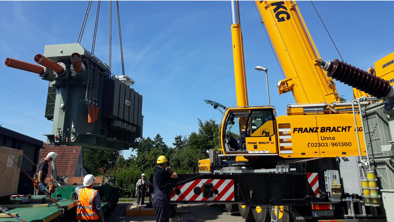
Beinahe Millimeter-Arbeit: Der 73 Tonnen schwere Transformator wird per Autokran an seinen Standort gehievt.
