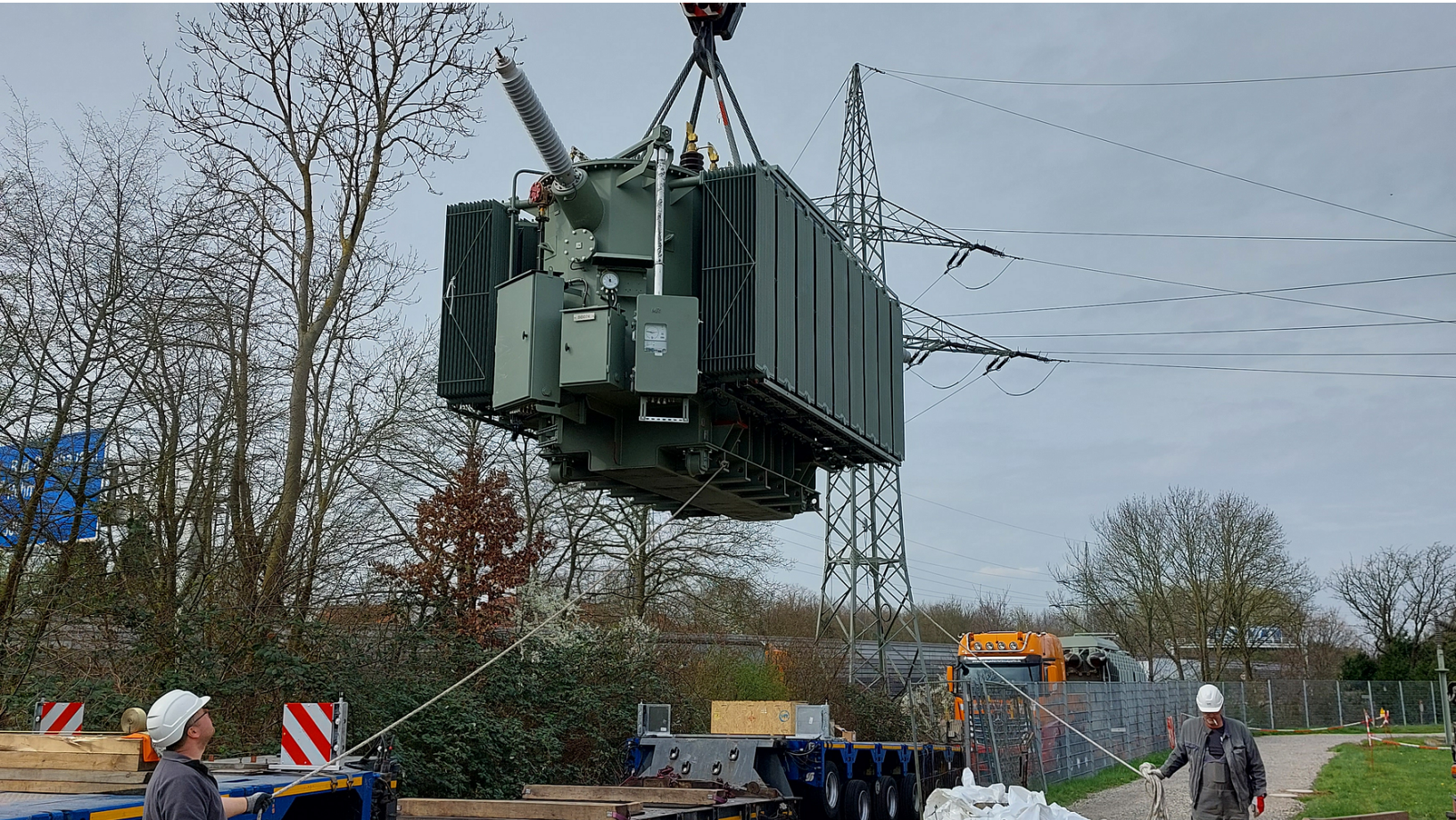
Ein Kran hievt das Kraftpaket an seinen Standort im Umspannwerk Rehme
